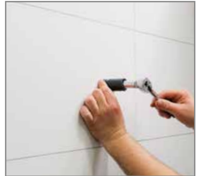
Montera beslaget på väggen.
