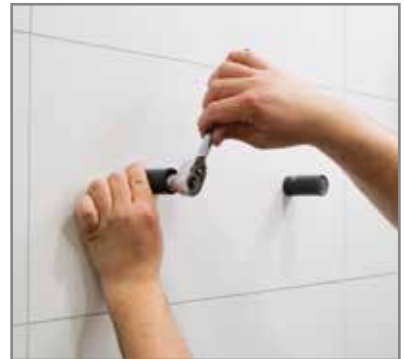
Montera det andra beslaget på väggen och justera.
