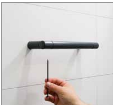
Skruva i ställskruvar och dra åt.
